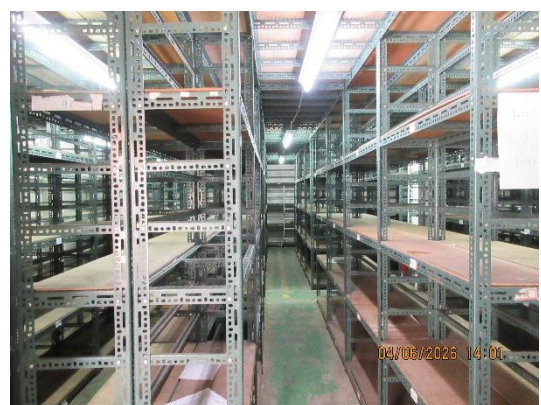
角鋼架拆除，連同燈具、木板一起清運
