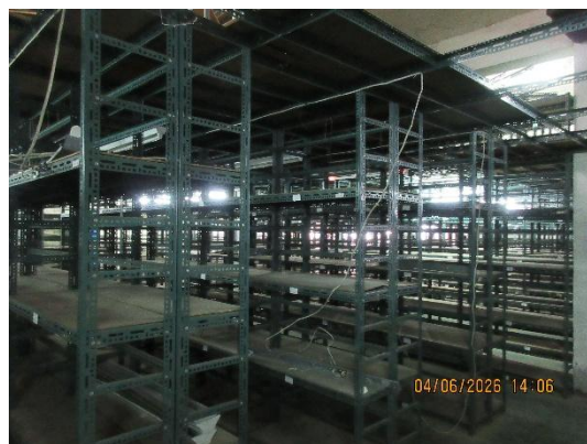
角鋼架拆除，連同燈具、木板一起清運
