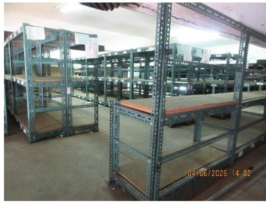
角鋼架拆除，連同木板一起清運，天花板上之燈具不需拆除
