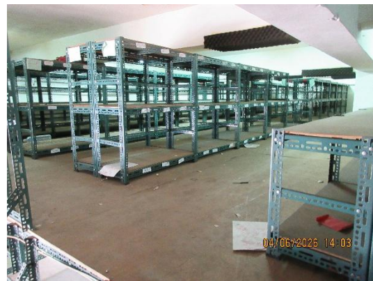
角鋼架拆除，連同木板一起清運，天花板上之燈具不需拆除
