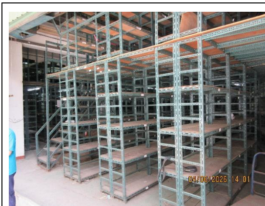
角鋼架拆除，連同燈具、木板一起清運
