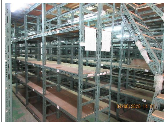
角鋼架拆除，連同燈具、木板一起清運
