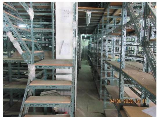
角鋼架拆除，連同燈具、木板一起清運
