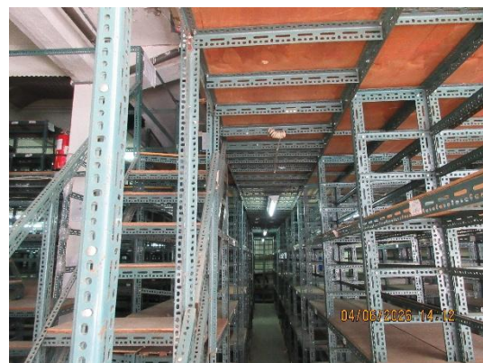
角鋼架拆除，連同燈具、木板一起清運
