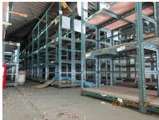
角鋼架拆除，連同燈具、木板一起清運
